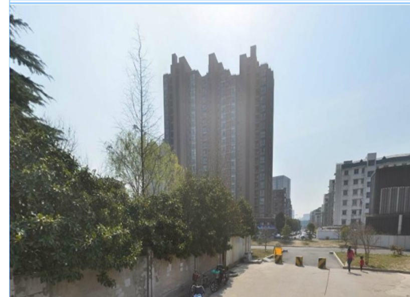
图 3-8 焦家村公交中心站阻隔围墙
